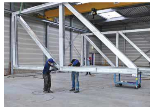
In de voorbehandeling wordt het staalconstructiewerk zo schoon en glad mogelijk gemaakt
