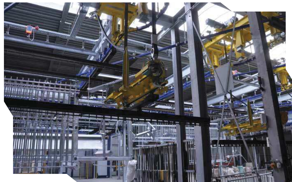
Eén van de dropsecties waar de traverse op hoogte kan worden gebracht om materiaal op te hangen of af te halen.
